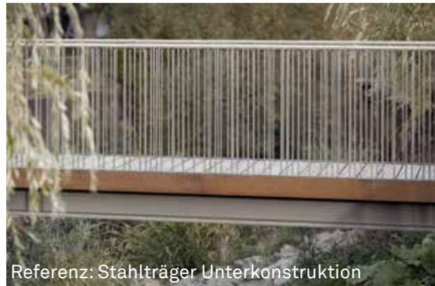
Referenz: Stahlträger Unterkonstruktion
