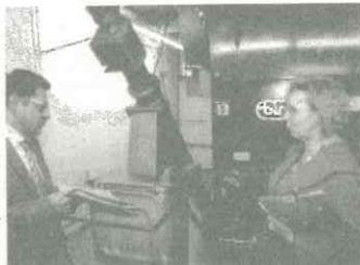
Im Jahr 2009 nahm Bürgermeisterin Marlies Sieburg die Holzpellettheizung im Rathaus in Betrieb. Zwei Jahre später allerdings fiel das Aggregat wegen einer technischen Störung zwei Monate lang aus, bis Experten den Fehler entdeckten.
