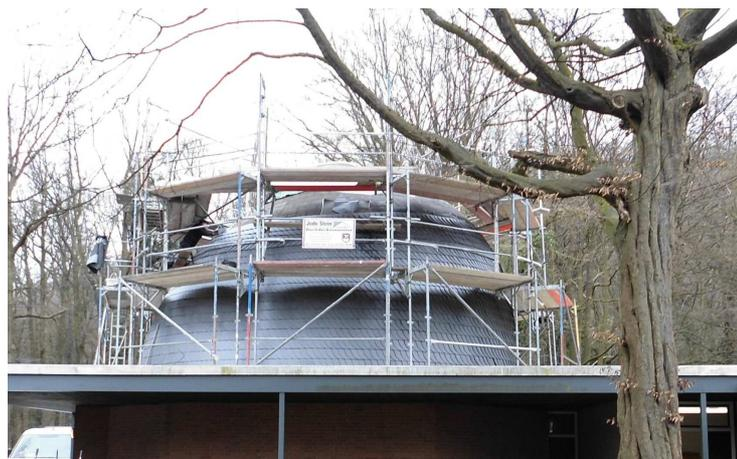
Die asymmetrische Kuppel der Friedhofshalle, deren massive Schale zur Eindeckung mit einer Holzkonstruktion verkleidet und mit einer Bitumenunterspannbahn belegt ist, erhält eine Schiefereindeckung. Vor zwei Wochen wurde mit den Einrüstungsarbeiten begonnen und seit letzter Woche belegt eine auf Schieferverlegung spezialisierte Fach-
